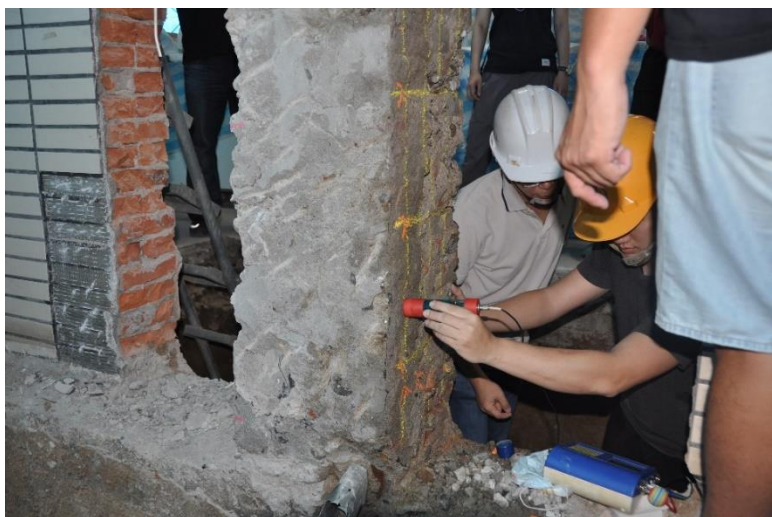
圖 A-5 現地鋼筋腐蝕電位量測試驗照片
